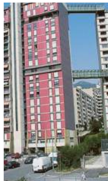
La Diga di Begato
