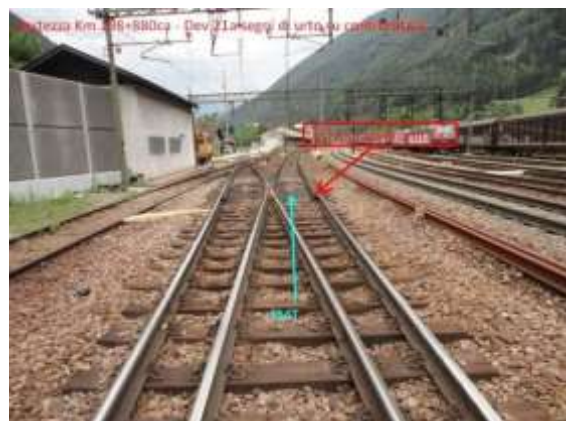
Figura 13 Fortezza segni deviatoio 21a (Foto RFI)
