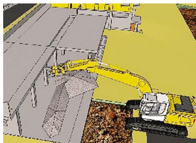
I mezzi smantelleranno le torri pezzo per pezzo
